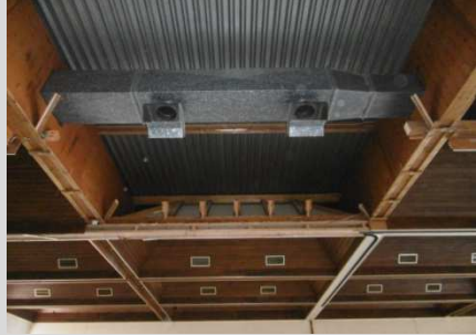
Neue und alte Lüftungstechnik sowie Deckenstrahlheizung und LED Beleuchtung
