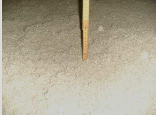
Neue 27 cm starke Zellulosedämmung
