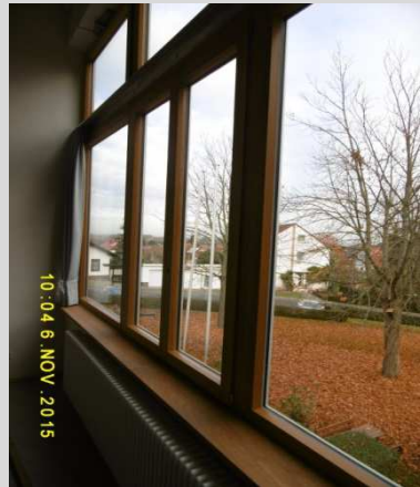
Neue Holz-Aluminiumfenster gemäß EnEV
