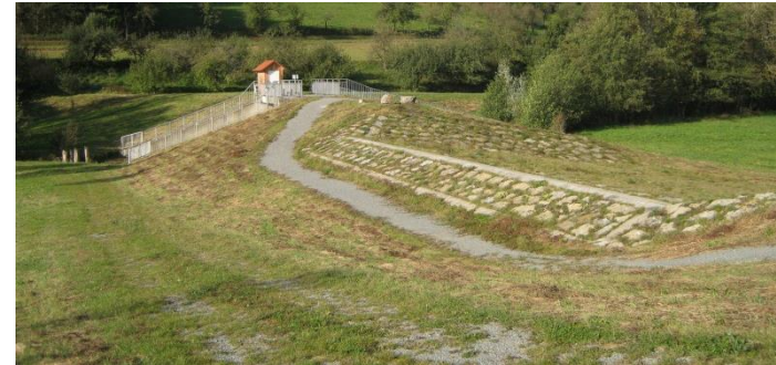
Teilweise überströmter Damm Abfluss über eine Dammscharte
