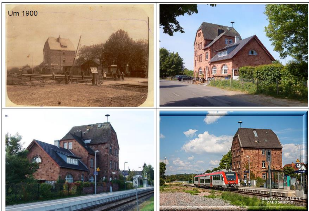
Abbildung 1: Ehemaliges Bahnhofsgebäude (außerhalb Plangeltungsbereich)
