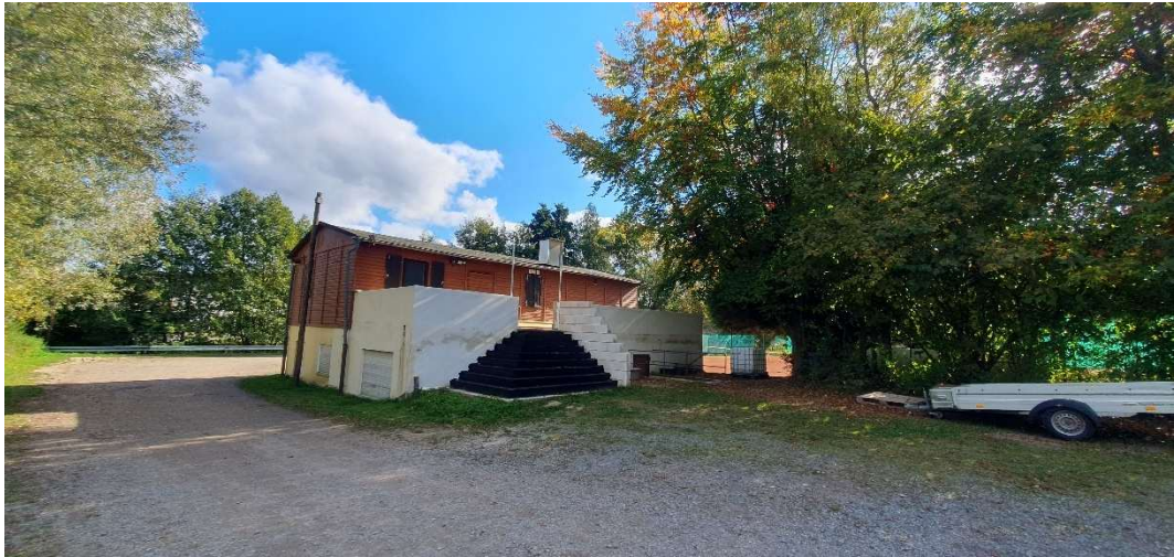
Vereinsheim der SpVgg 1928 Groß-Umstadt e.V. mit Terrassenanbau (Nordwestansicht)
