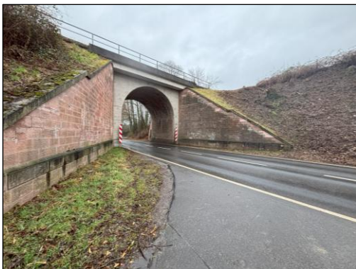
Blick auf die Zufahrt in Richtung der Bahnbrücken-Unterführung
