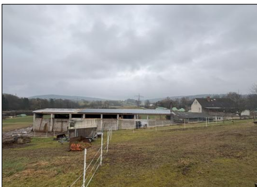
Blick hangabwärts auf die Hallen in südliche Richtung
