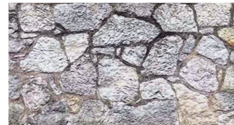
Abb. 8: Bruchsteinmauer
