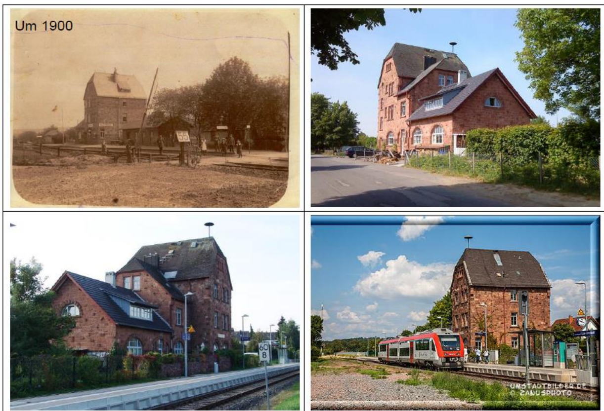
Abbildung 1: Ehemaliges Bahnhofsgebäude (außerhalb Plangeltungsbereich)
