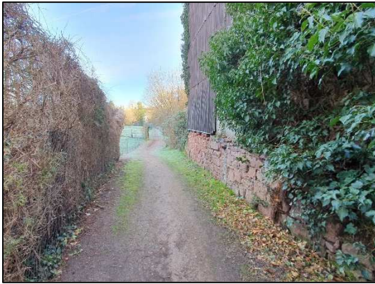
Blick Fußweg mit Gebäudebestand (Scheune Auf der Gasse 12)
