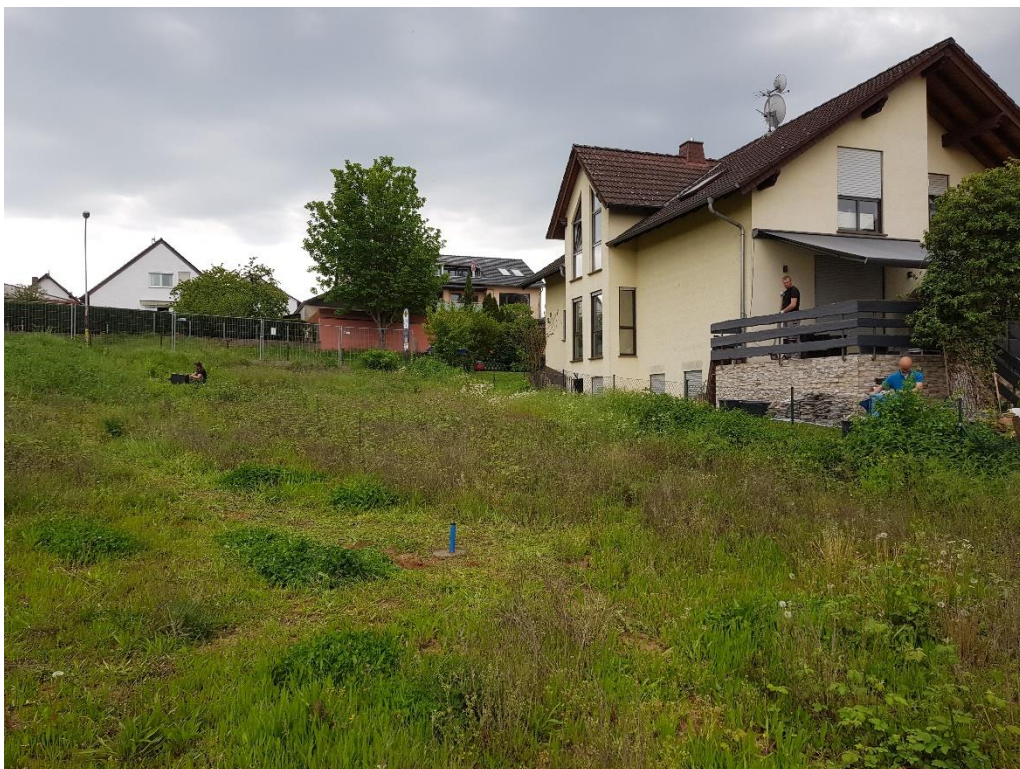
Abb. 2 Ansicht des Baufelds mit dem nördlichen Nachbarhaus
