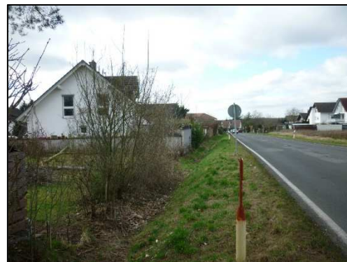
Entwässerungsgraben entlang der L 3115
